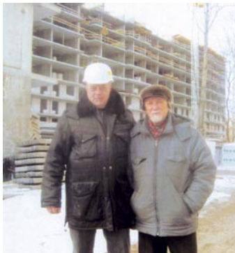
На строительстве общежитий в МСГ. СПб., 2012 г.
